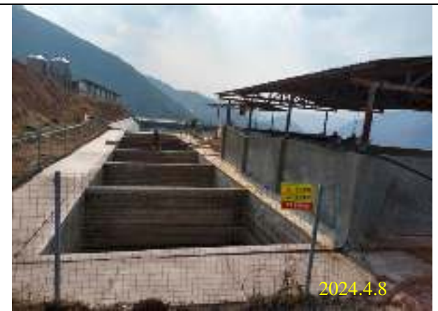
二三小区粪污处理站
