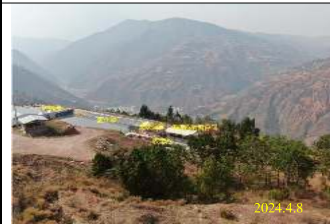
二三小区粪污处理站
