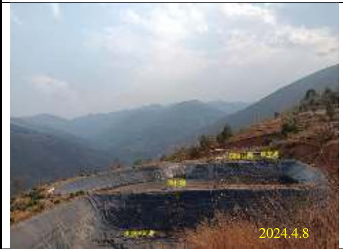
一小区污水处理站
