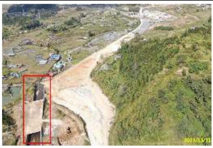
河道改移起点
