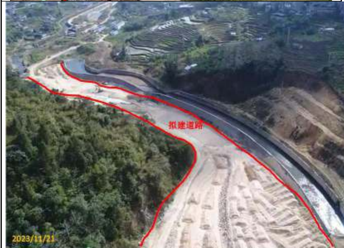
3、征地范围内的施工便道情况
